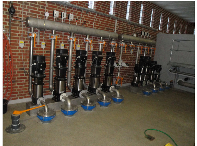
Frekvensstyrede rentvandspumper.
