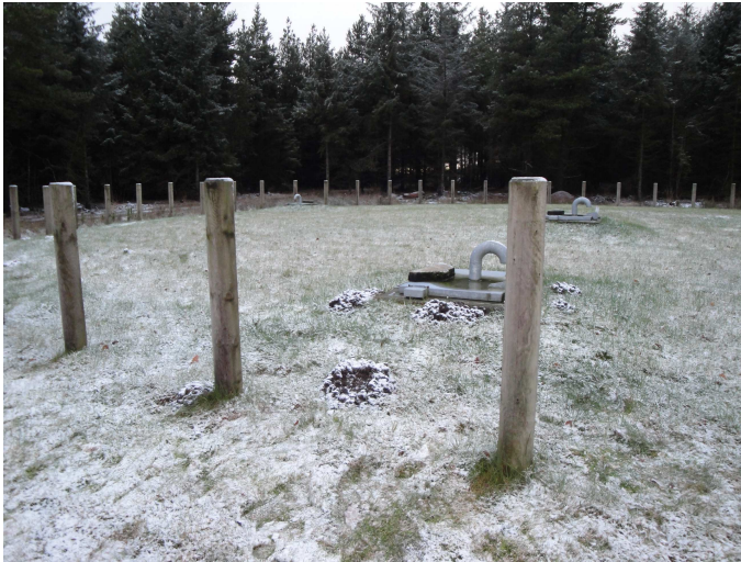
Nedgravet rentvandsreservoir med muldvarpeskud.
